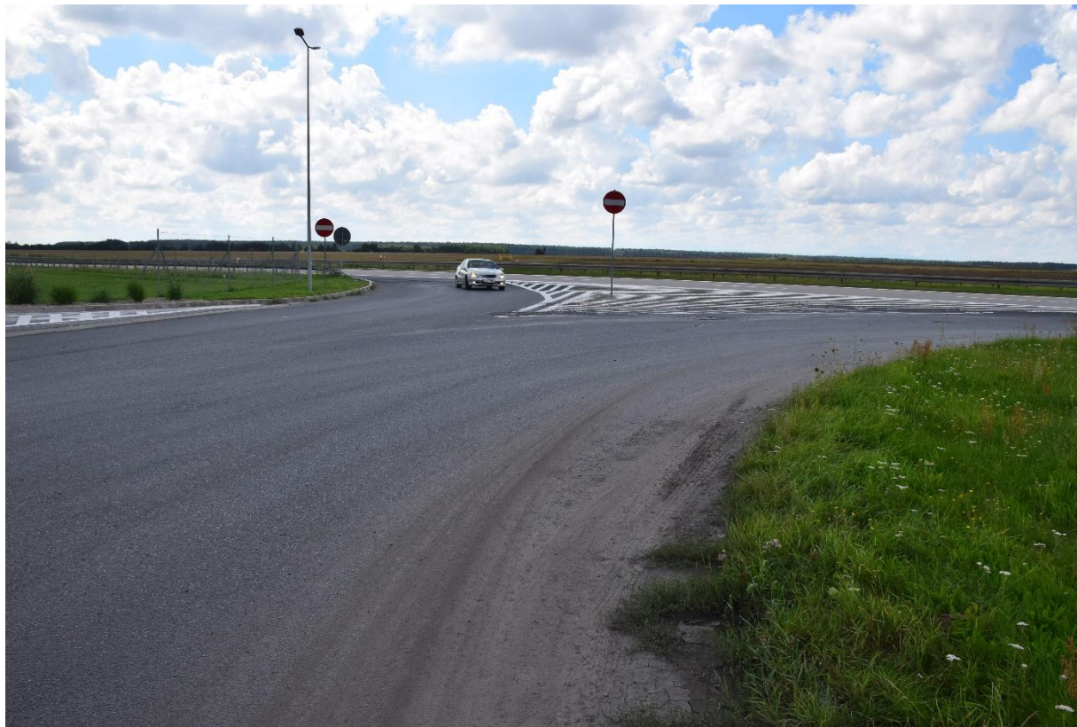
Widok ustawienia znaku B-2 na powierzchni wyłączonej z ruchu liniami P-21
