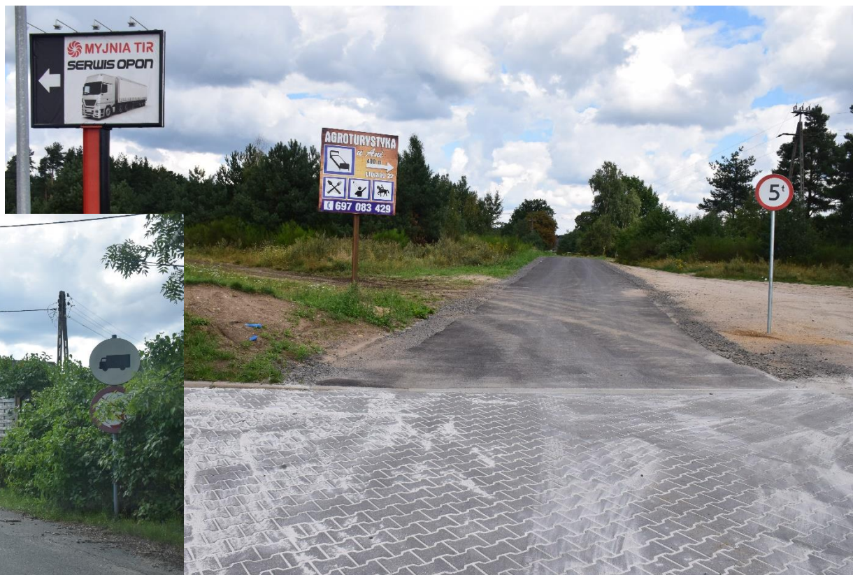
Widok zjazdu z MOP na drogę gminną
