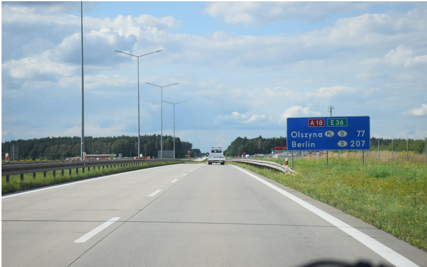
Widok ogólny jezdni północnej autostrady A18 w rejonie km 75+100
