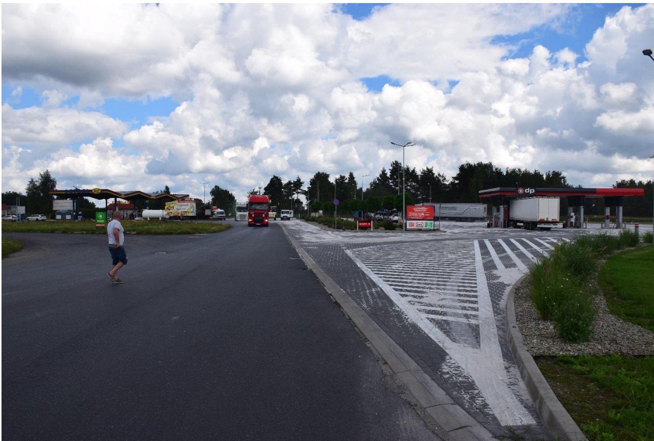
Widok dróg na terenie MOP Lipiany Północ
