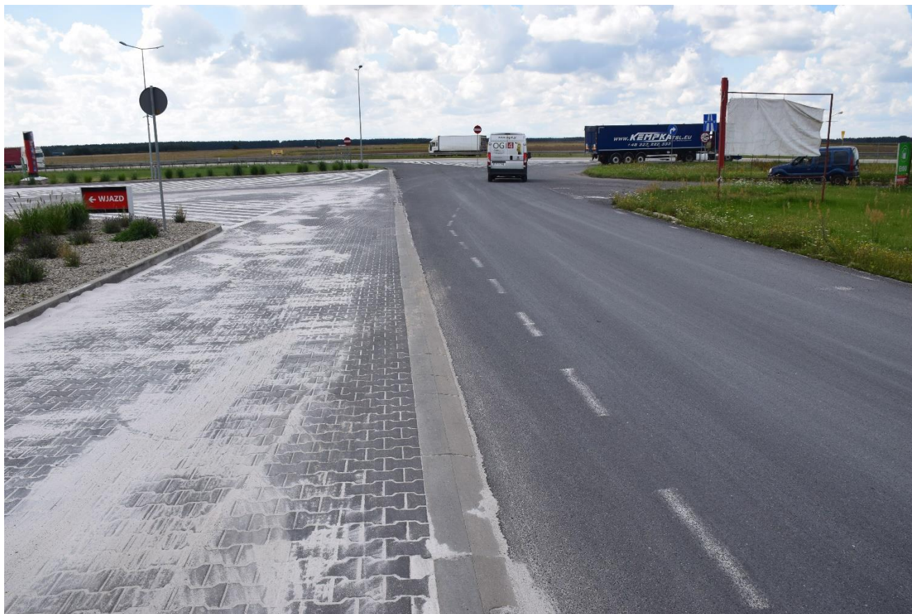
Widok dróg na terenie MOP Lipiany Północ
